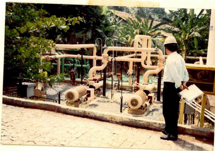
Novas bombas de transferência de salmoura.
