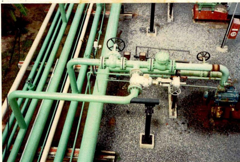
Sucção tanque d'agua Descarga para injeção nos poços de sal (OESTE) Descarga para injeção nos poços de sal (LESTE)
