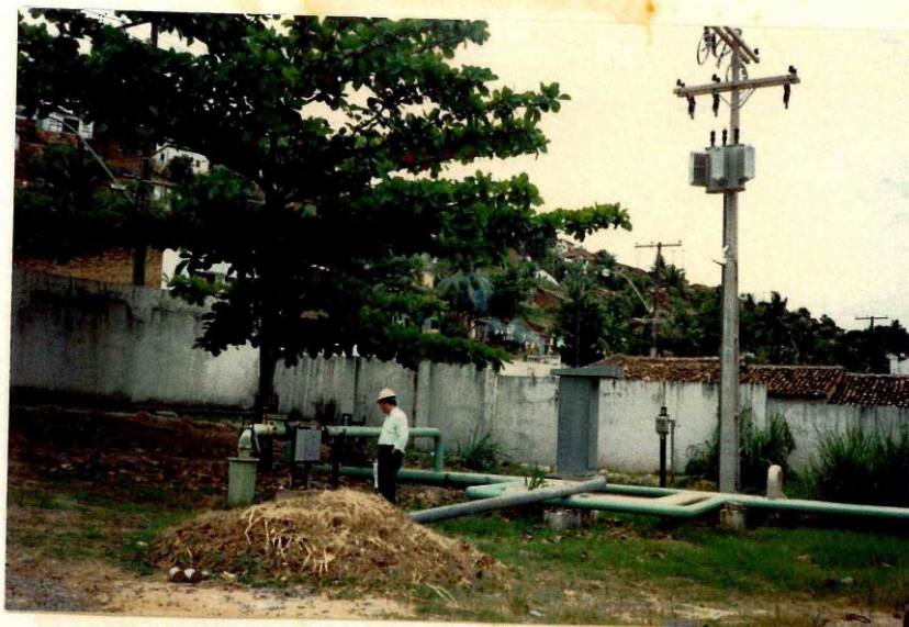
Poço d'agua nº 17 Painel elétrico e Transformador.
