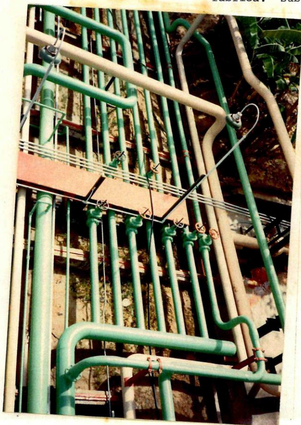
Linhas (6") poços d'agua. Cada linha conduz para o tanque d'agua, Água de dois poços. Total de linhas 7.
