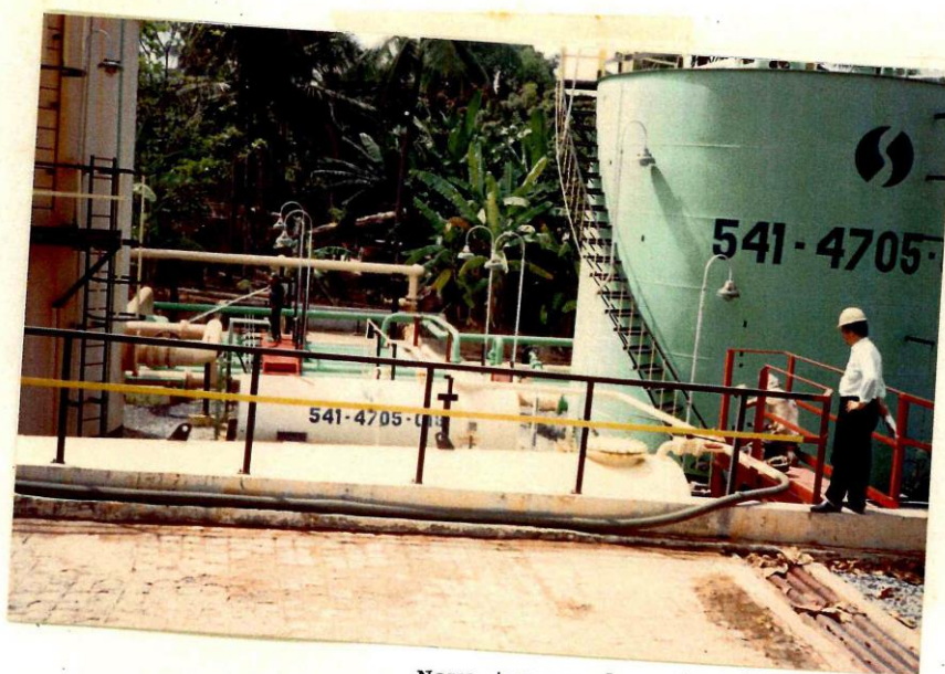
Novo tanque de soda cáustica
