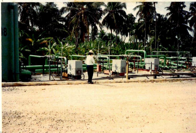
Bombas de injeção d'agua (03) (injeta água nos poços de sal)
